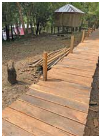
Reconstrução da passarela destruída pela cheia
